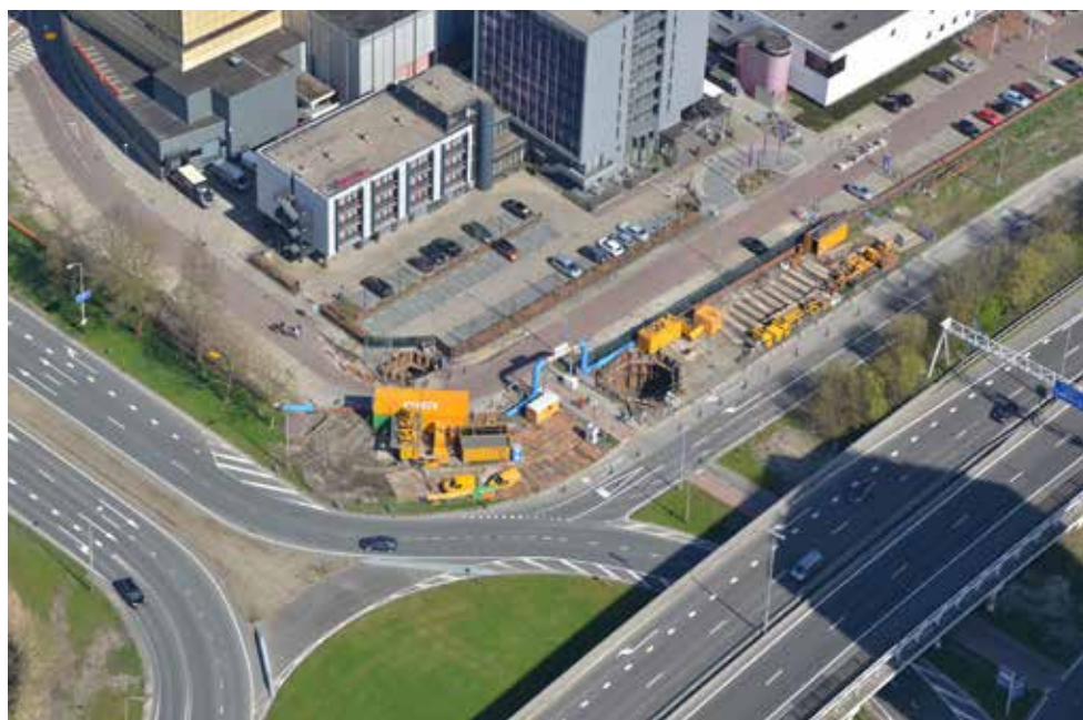
HET VERLEGGEN VAN RIOLERING BIJ HET VRIJHEIDSPLEIN, VANUIT DE LUCHT GEZIEN. FOTO: RIJKS WATERSTAAT.
