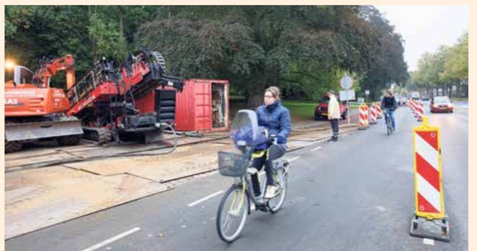
IN OKTOBER VAN DIT JAAR VOERDE ENEXIS EEN 'GESTUURDE BORING' UIT ONDER HET STERREBOS. DE BOORKOP GING BIJ DE HEREWEG DE BODEM IN EN GING 14 METER ONDER DE GROND DOOR. FOTO: JEROEN VAN KOOTEN.
