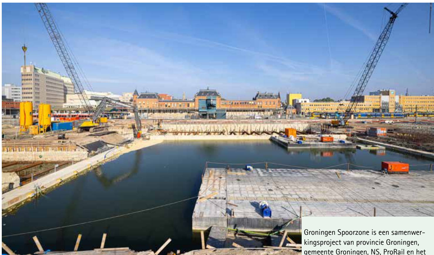
Bouwput voor onderwaterbeton aan de zuidzijde van het stationsgebouw. Foto: Stefan Verkerk.
