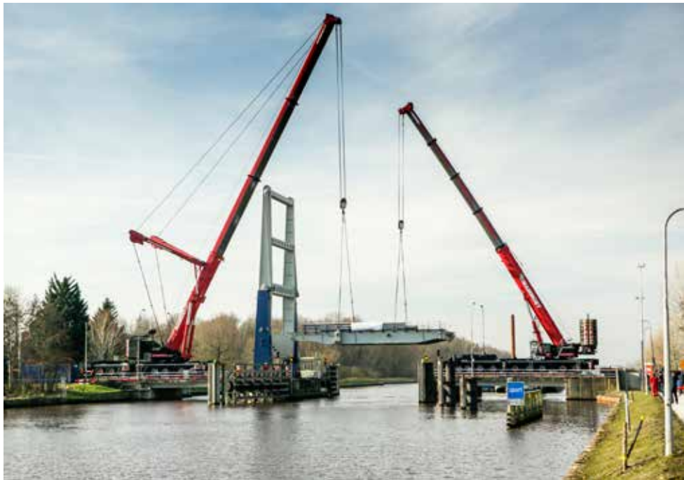
DE BORGBRUG OVER HET EEMSKANAAL BIJ MEERSTAD WERD IN DECEMBER 2018 AANGEVAREN. IN FEBRUARI 2019 KON DE GEREPAAREDE BRUG WORDEN TERUGGEPLAATST. FOTO: RIJKSWATERSTAAT/HENK VEENSTRA.
