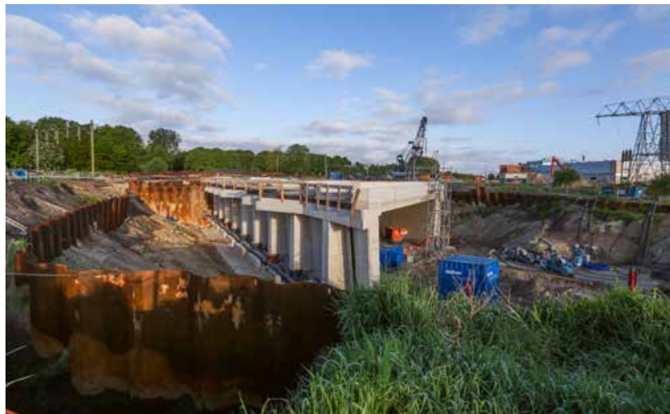
IN DE ZOMERVAKANTIE WORDT DE HELPERZOOMTUNNEL OP ZIJN PLEK ONDER HET SPOOR GESCHOVEN. DE TUNNEL IS NAAST HET SPOOR AL VOORGEBOUWD. FOTO: BOUWFOTOGRAFE.NL.
