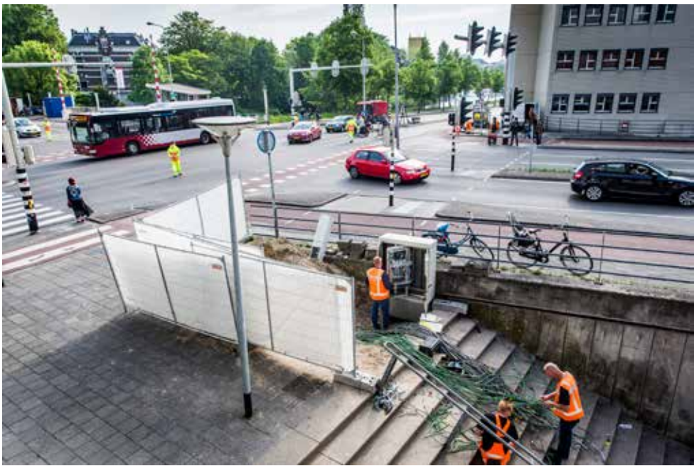
MONTEURS VERVANGEN DE VERKEERSREGELINSTALLATIES BIJ DE STATIONSWEG IN GRONINGEN. FOTO: SIESE VEENSTRA.
