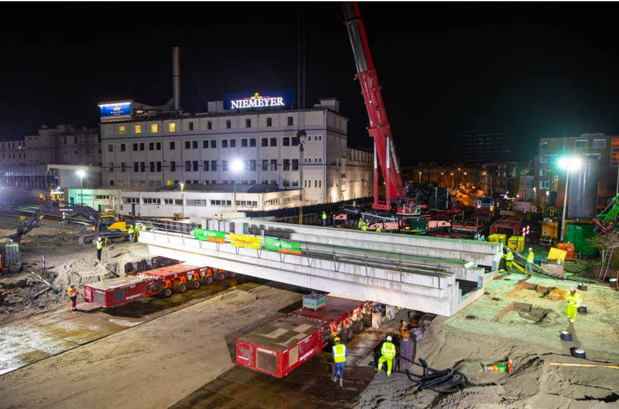
IN OKTOBER IS HET SPOORDEK BIJ DE PATERSWOLDSEWEG IN GRONINGEN GEPLAATST. HIERVOOR WERD HET TREINVERKEER RICHTING FRIESLAND EN NOORD-GRONINGEN STILGELEGD. HET WERK GING DAG EN NACHT DOOR. FOTO: STEFAN VERKERK.
