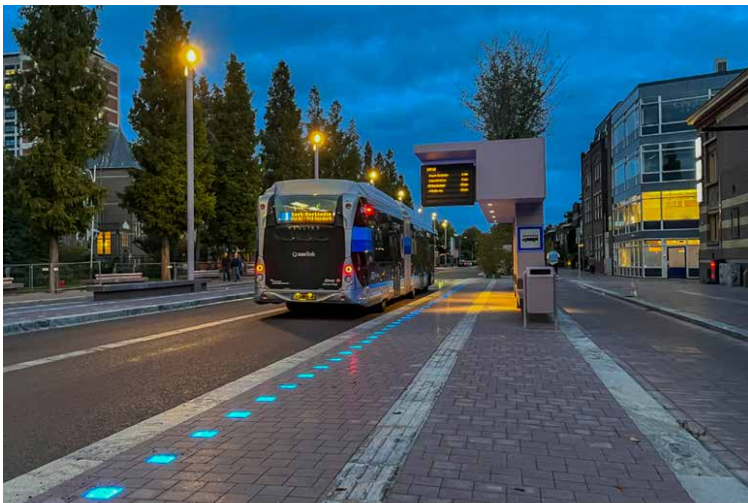
Het nieuwe busknooppunt UMCG Noord met groen op de abri's. De ledverlichting in het perron kleurt mee met de kleur van de buslijn die er als eerste stopt. Foto: OV-bureau Groningen Drenthe.
