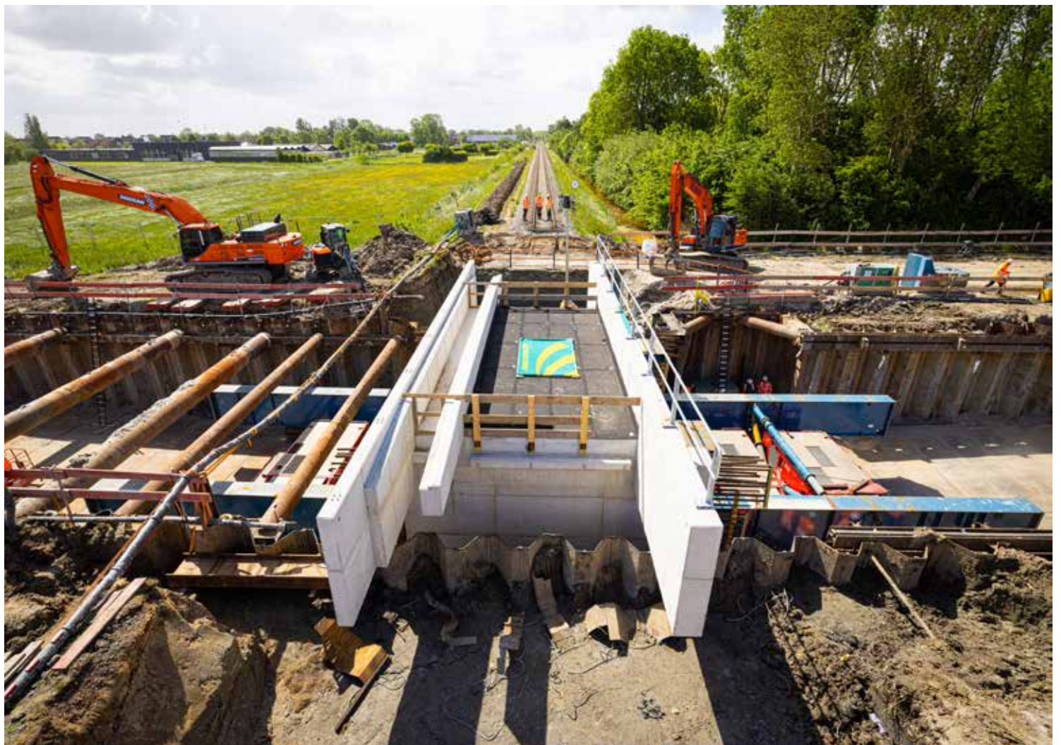
De nieuwe weg bij Winsum gaat onder het spoor door. Hiervoor heeft ProRail afgelopen mei in het hemelvaartweekend verschillende werkzaamheden uitgevoerd en een nieuw tunneldek in één keer op z'n plaats gereden. Foto: Stefan Verkerk.
