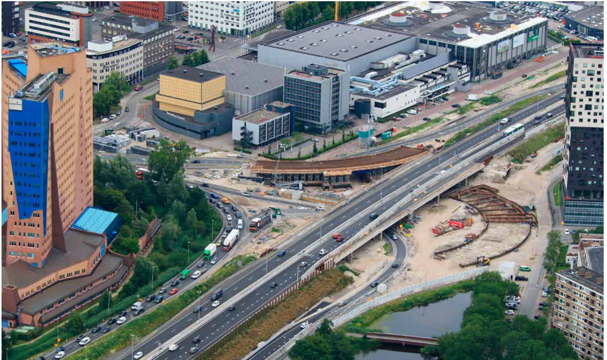
Beeld van de werkzaamheden aan het Vrijheidsplein en de aansluiting op Ring West. Ook zichtbaar is het werk aan de verbindingbogen. Foto: Rijkswaterstaat.
