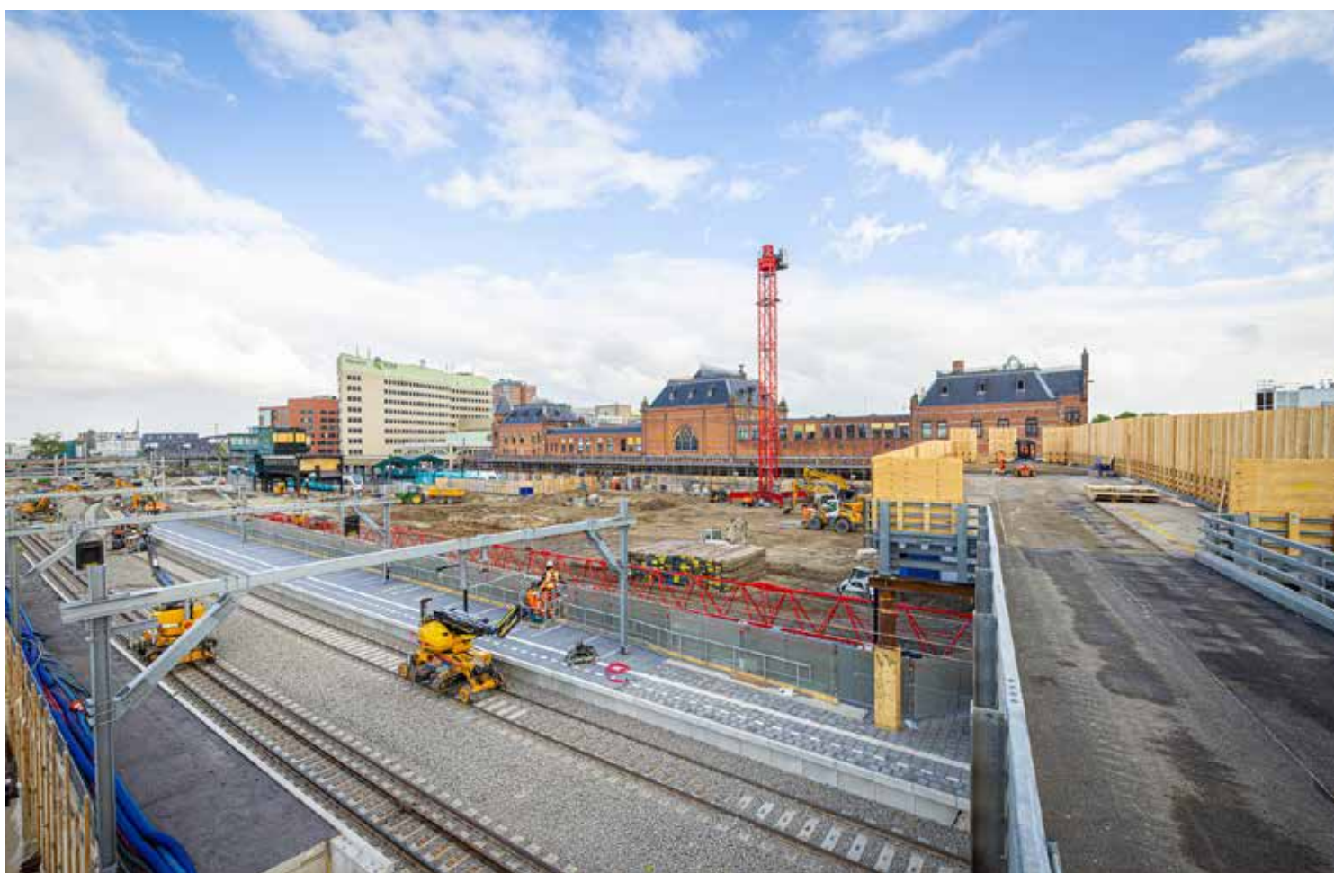
Aan de achterzijde van station Groningen wordt volop gewerkt. Foto: Stefan Verkerk.
