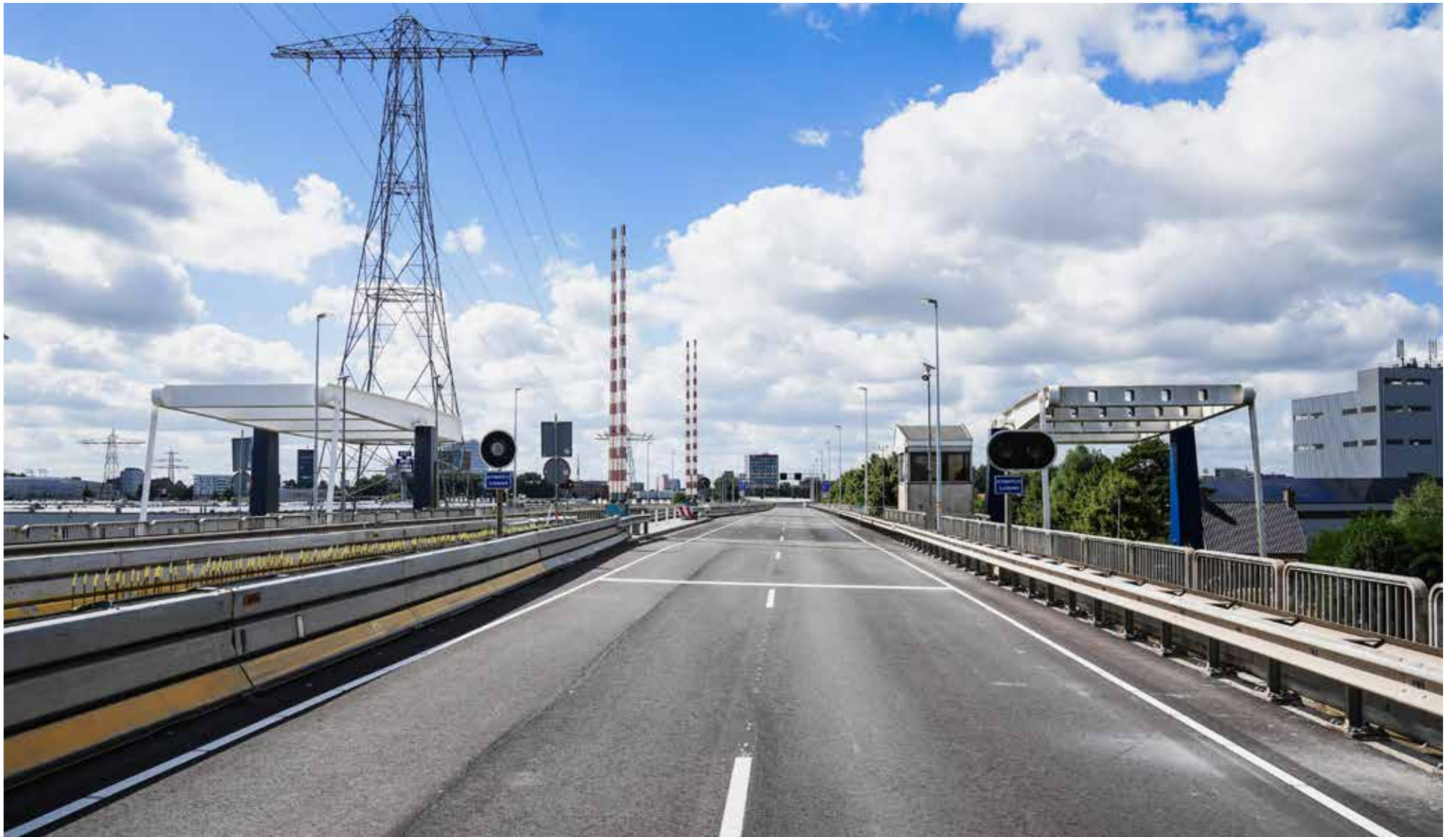
De hoge Euvelgunnerbrug in de zuidelijke ringweg van Groningen wordt deze zomer compleet vervangen. Foto: Raymond Bos.
