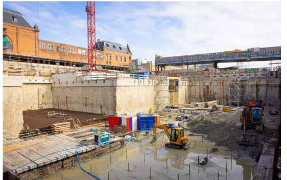
De bouwkuip achter het station waarin de reizigerstunnel wordt gebouwd. Foto: Stefan Verkerk.
