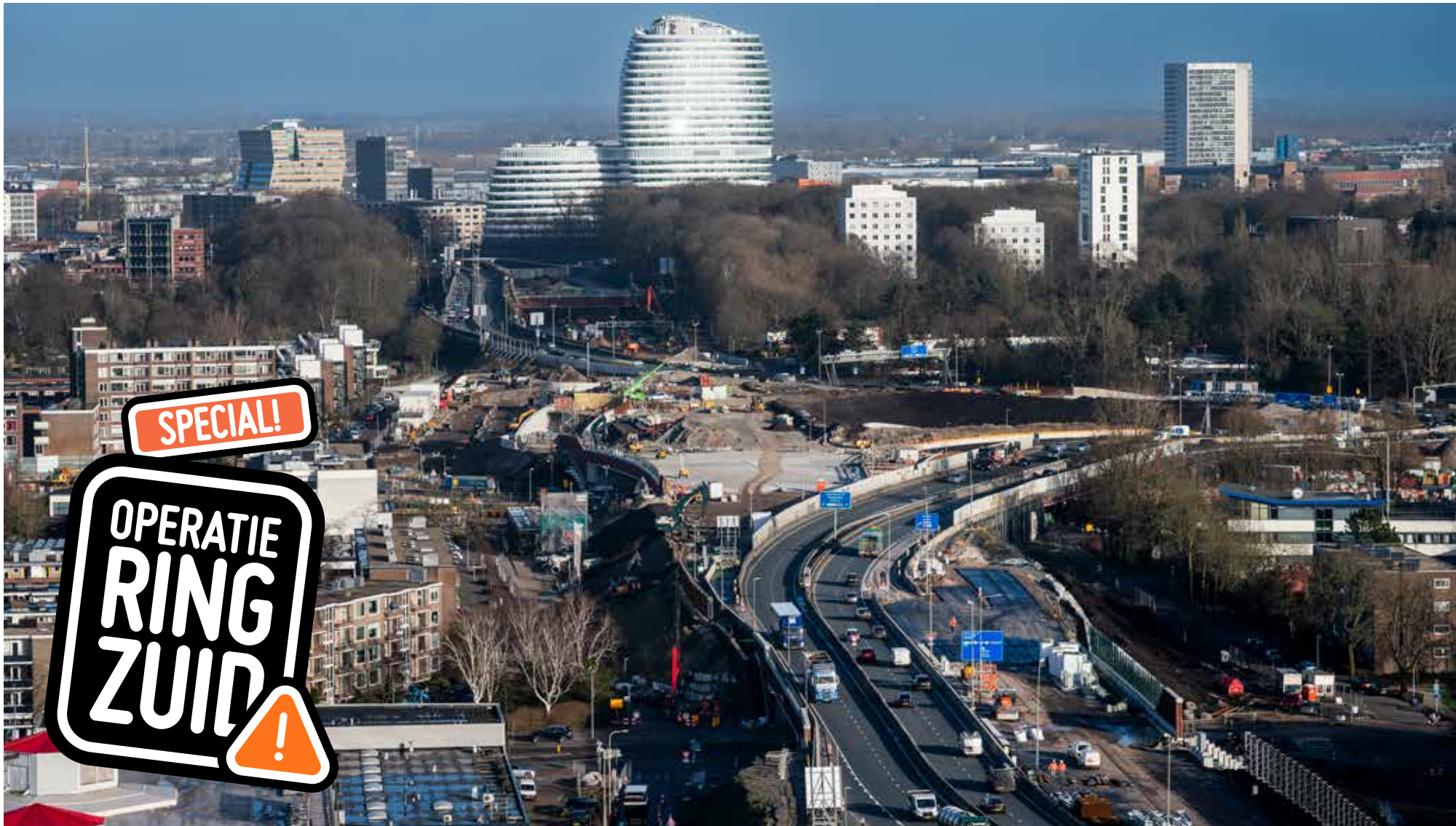
Zicht op de gigantische werkzaamheden aan het Julianaplein. De zuidelijke ringweg, inclusief dit plein, gaat de komende maanden in fasen dicht. Foto: Siese Veenstra.
